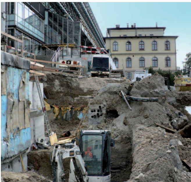
In den kommenden Monaten wird die Baugrube aus dem Fels gesprengt. (Bild ETH Zürich)
